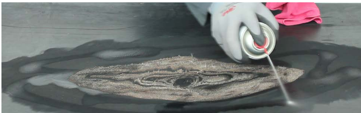
Рис. 2.11.1 – Применение обезжиривающего аэрозоля
