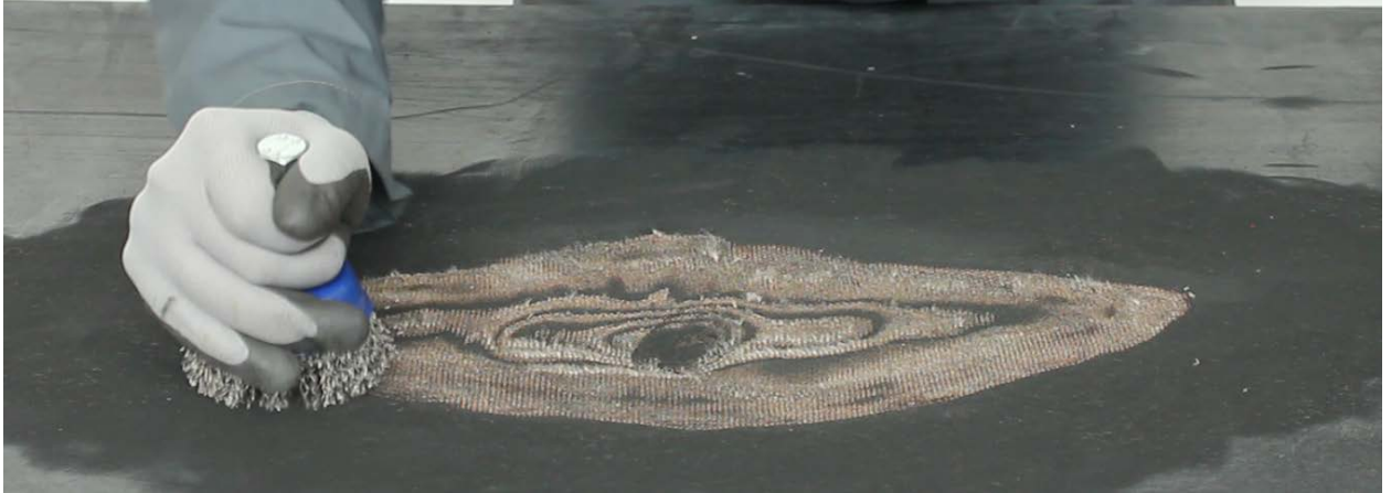
Рис. 2.7.1 – Обработка ленты щеткой с крупным металлическим ворсом
