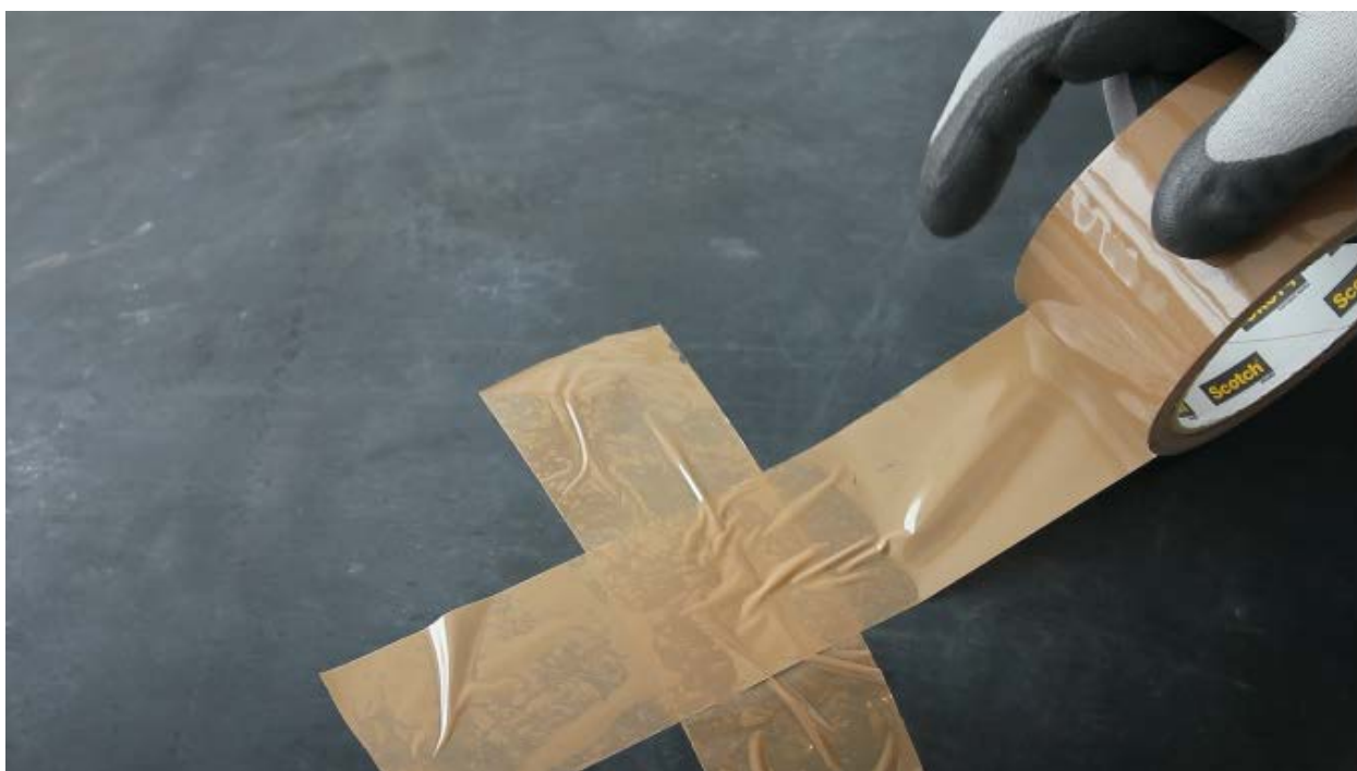
Рис. 2.5 – Заклейка сквозного отверстия с обратной стороны ленты
