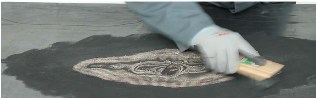
Рис. 2.10 – Очистка ленты щеткой-сметкой
