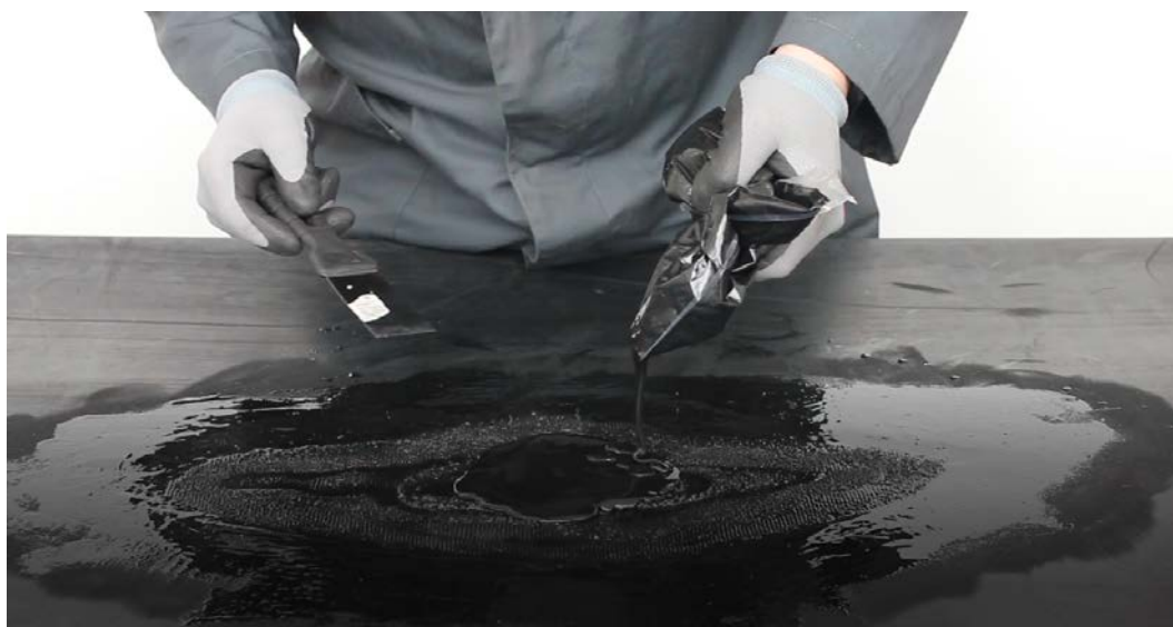
Рис. 2.21 – Начало процесса нанесения второго основного слоя компаунда
