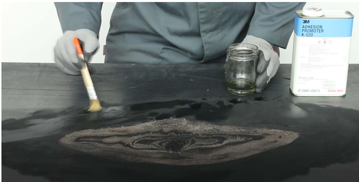
Рис. 2.14 – Нанесение праймера 3М К520
