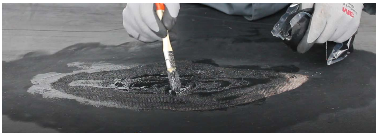
Рис. 2.19 – Нанесение первого тонкого слоя компаунда 3M Scotchcast 2131 при помощи кисти
