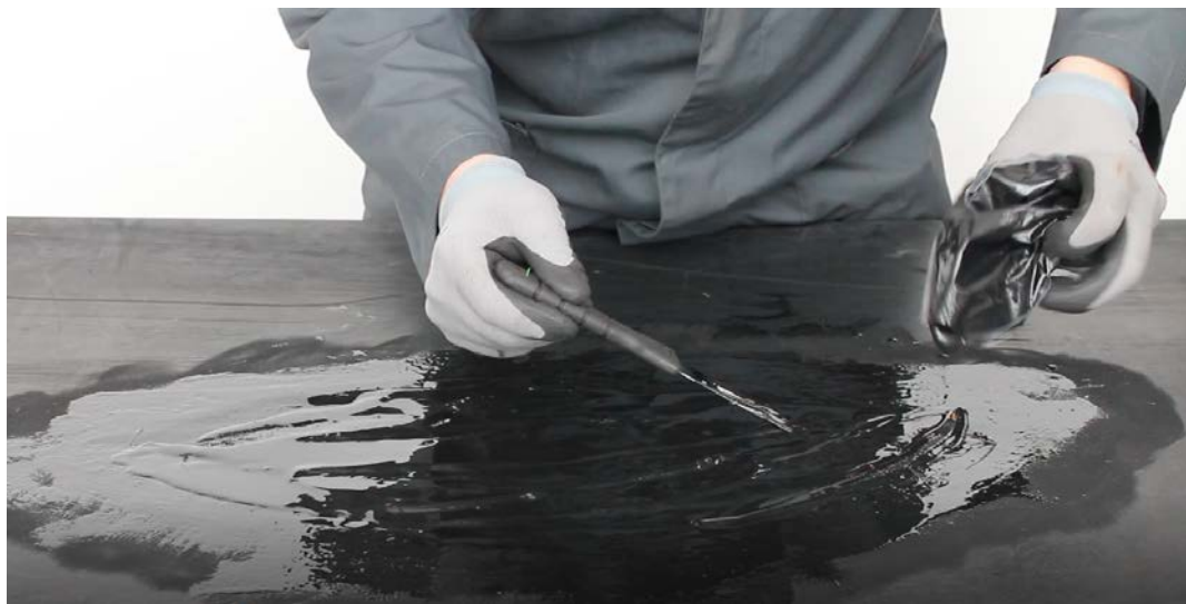
Рис. 2.22.1 –Нанесение второго основного слоя компаунда при помощи шпателя
