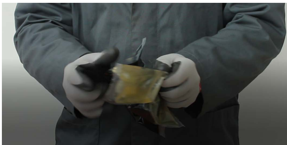
Рис. 2.16.1 – Перемешивание содержимого пакета с компаундом 3M Scotchcast 2131
