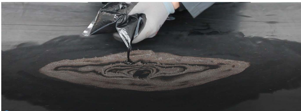
Рис. 2.18 – Начало процесса заливки компаунда 3M Scotchcast 2131
