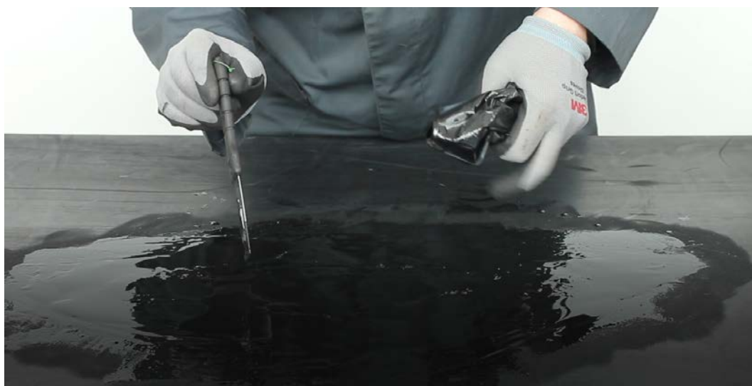
Рис. 2.22.2 – Завершение процесса нанесения компаунда
